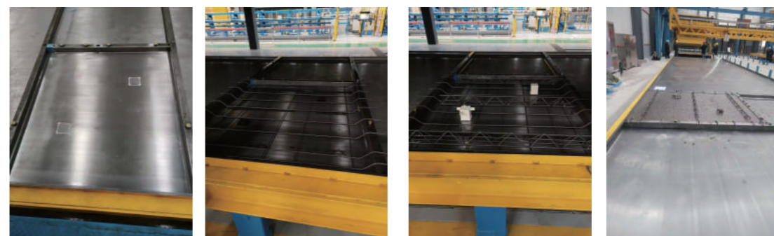
自动划线支模自动放置钢筋网片
